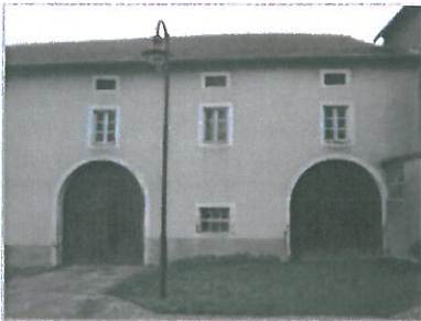
Figure 34 : Rue de Solenval (CDA88)
