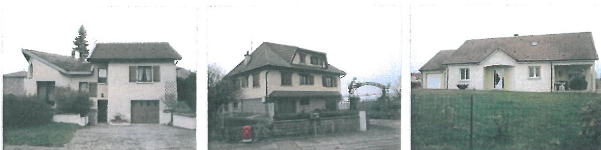
Figure 29 : Exemples de constructions plus récentes (CDA88)
