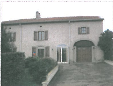
Figure 35 : Route de Mirecourt (CDA88)
