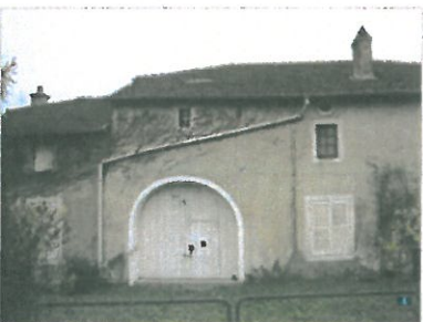
Figure 36 : Rue du Breuil (CDA88)
