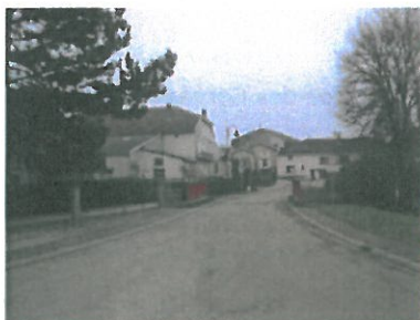
Figure 24 : Entrée par la route de Mirecourt (CDA88)
