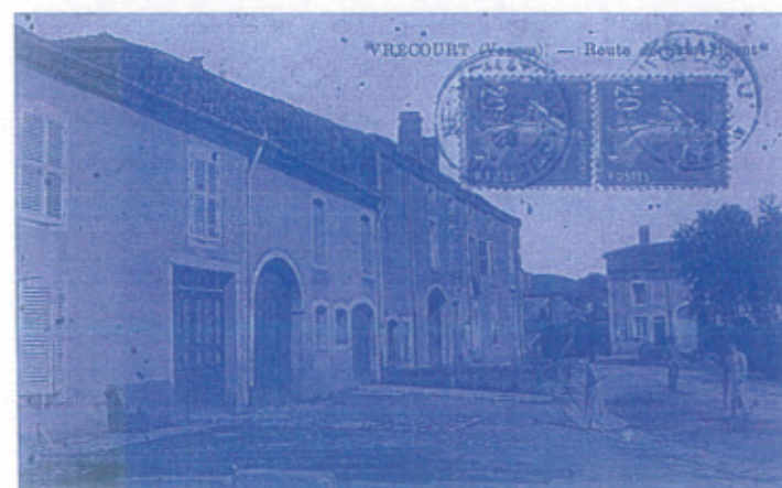
Route de Saint Ouen - AVANT
