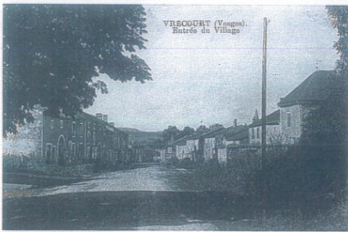
Entrée du village - AVANT
