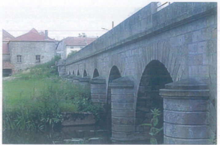
Le pont de pierre sur le Mouzon - APRES
