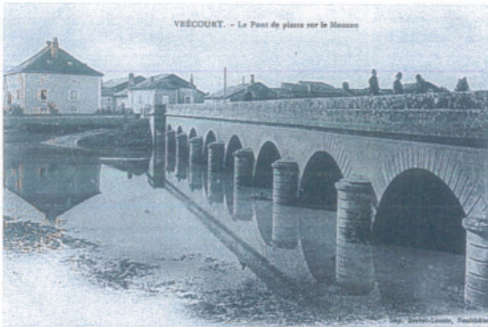
Le pont de pierre sur le Mouzon - AVANT
