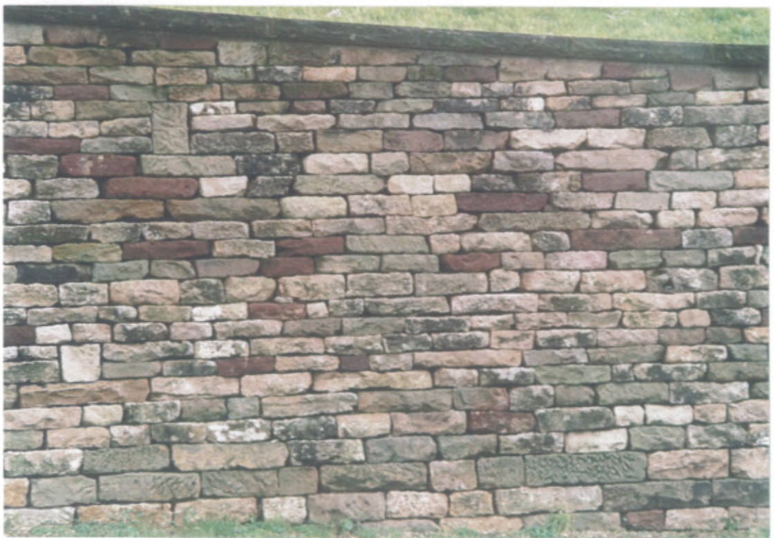
17 Mur et escalier en pierre
