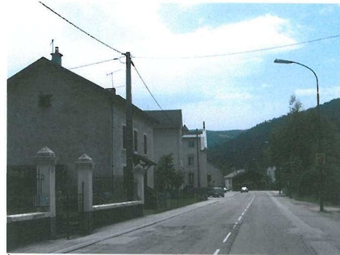
Les espaces publics manquent de structuration. Eclairage public à caractère routier.
