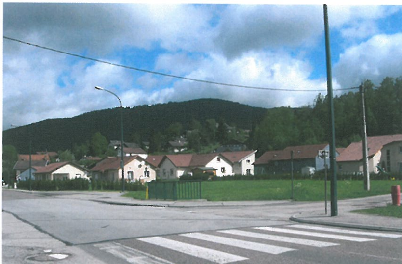
Les Roches de Fontaine : un nouveau quartier résidentiel se développant le long de la RD243, entre le centre bourg et Crémanvillers.
