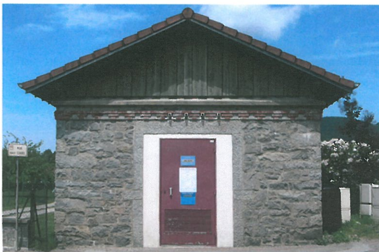
Petit bâtiment patrimonial accueillant un transformateur électrique.
