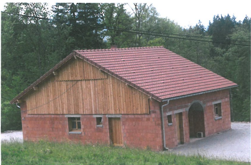
Construction récente présentant des éléments du bâti traditionnel lorrain : toiture à 2 pans, porte charretière et triangle de bois.
