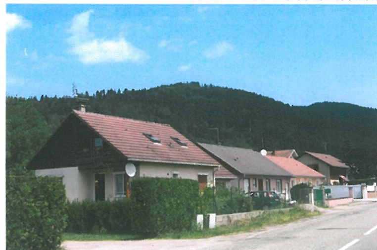
Faitages des toitures parallèles à la rue.
