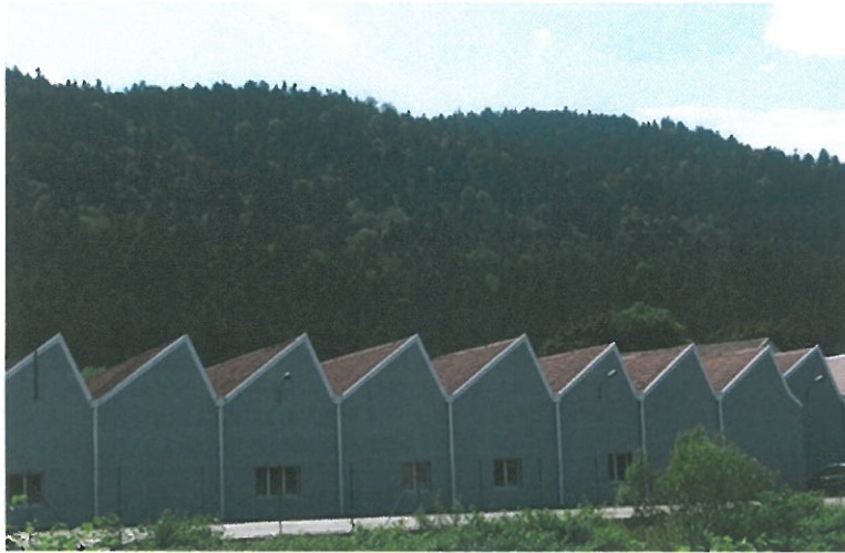
Très bonne intégration de l'usine à Zainvillers.
