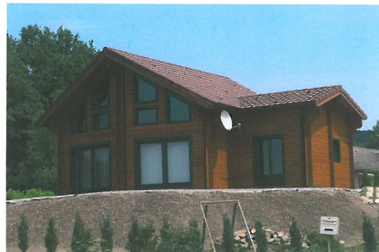
Nouvelle construction bois présentant une couleur orangée et une implantation sur "butte-taupinière".
