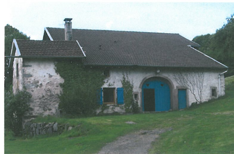
Façade perpendiculaire au sens de la vallée. Présence de porte charretière.
