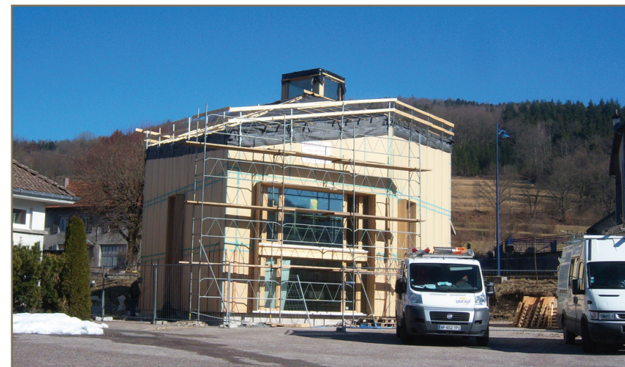
un accueil périscolaire est en cours de construction en coeur de centre bourg
