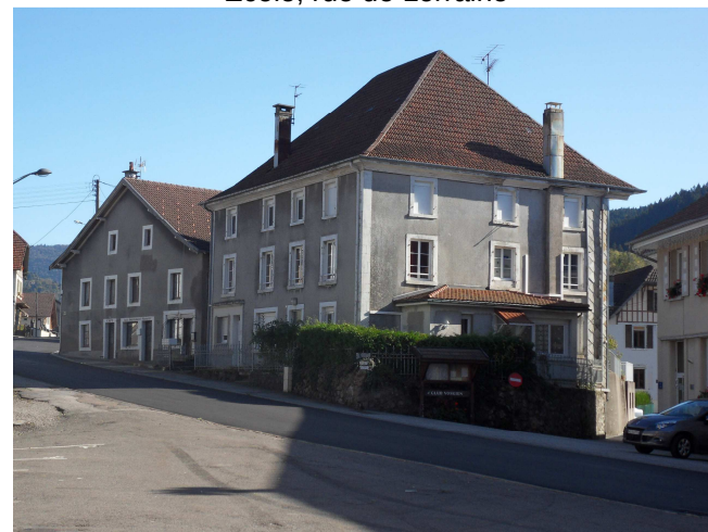
Habitations situées au-dessus de la mairie
