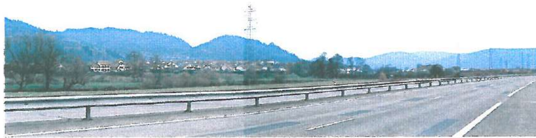
Vue depuis la RN 66, à la hauteur de la zone d'activités "la Joncherie"
