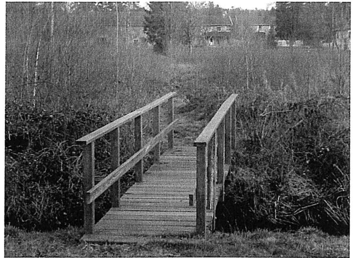
20- Passerelle bois, « Devant le Moulin »
