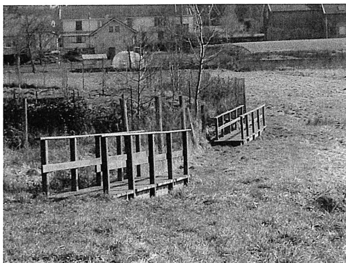
4- Passerelle bois, « Près de la Fontaine » :
