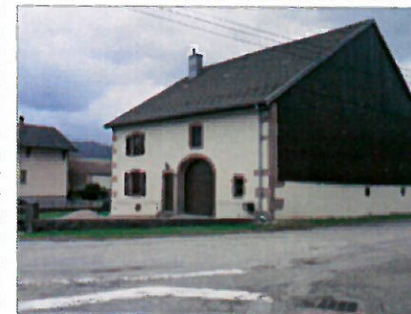
Ancienne ferme réhabilitée.
