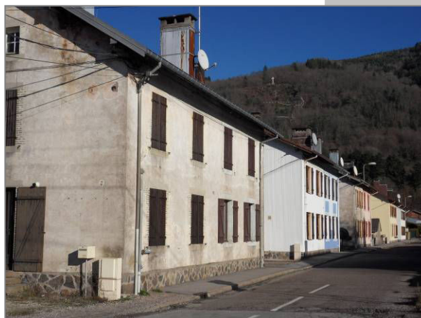
Maisons ouvrières, RUPT-SUR-MOSELLE
