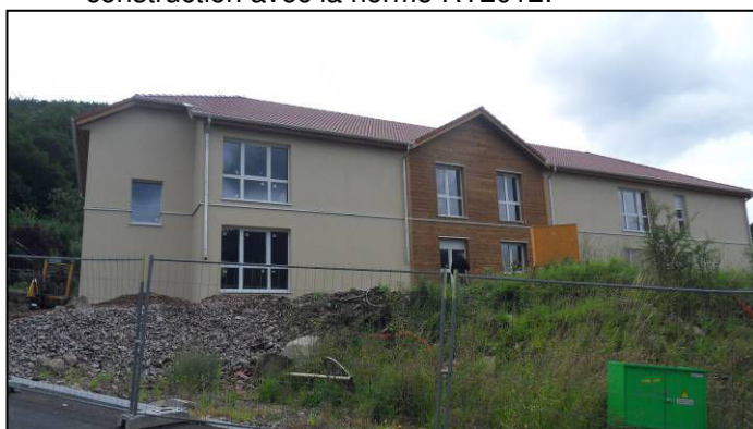
Bâtiment Vosgelis en construction
