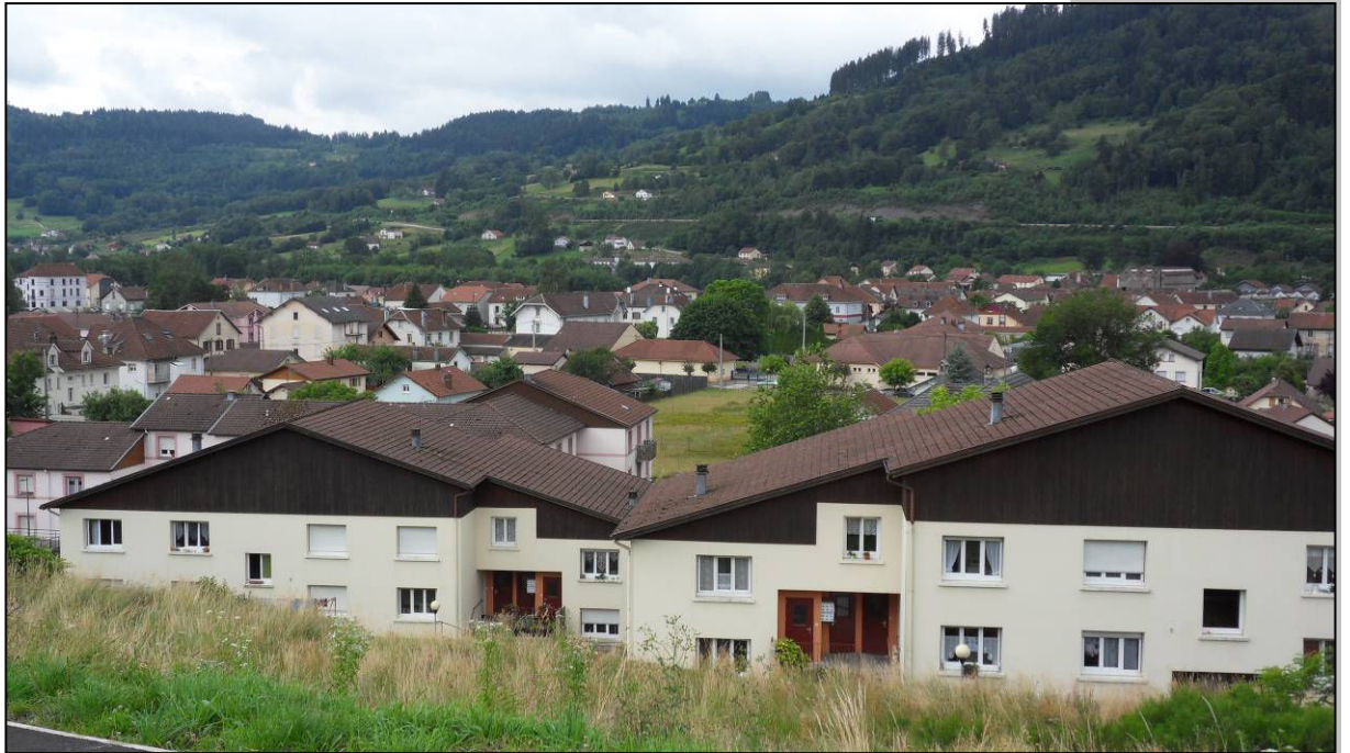
Vue depuis la rue de Parier (vallée urbanisée) : impact visuel de la RN66, vue sur le Gué Mozot
