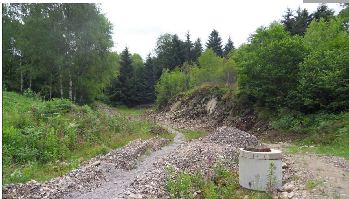
Les réseaux ont été amenés en limite de zone et une amorce de desserte est visible sur site
