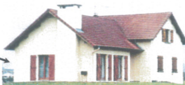
Maison contemporaine d'une architecture « banalisée »
