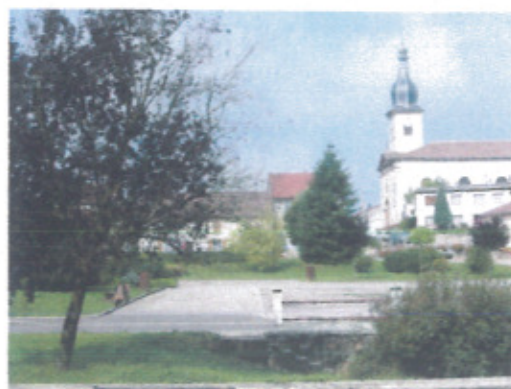
Vue depuis R.D.6 au centre du village
