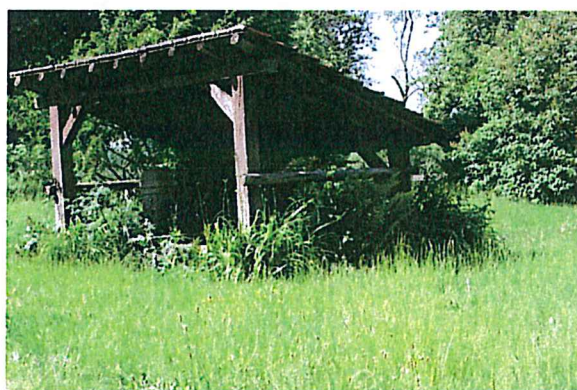
Lavoir à Raon centre
