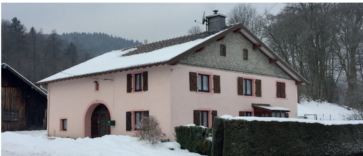
La ferme vosgienne (et son annexe), rassemblait sous le même toit les bêtes, le foin et la famille. L'abandon de l'activité agricole laisse au ménage un gros volume, aujourd'hui sous occupé.
