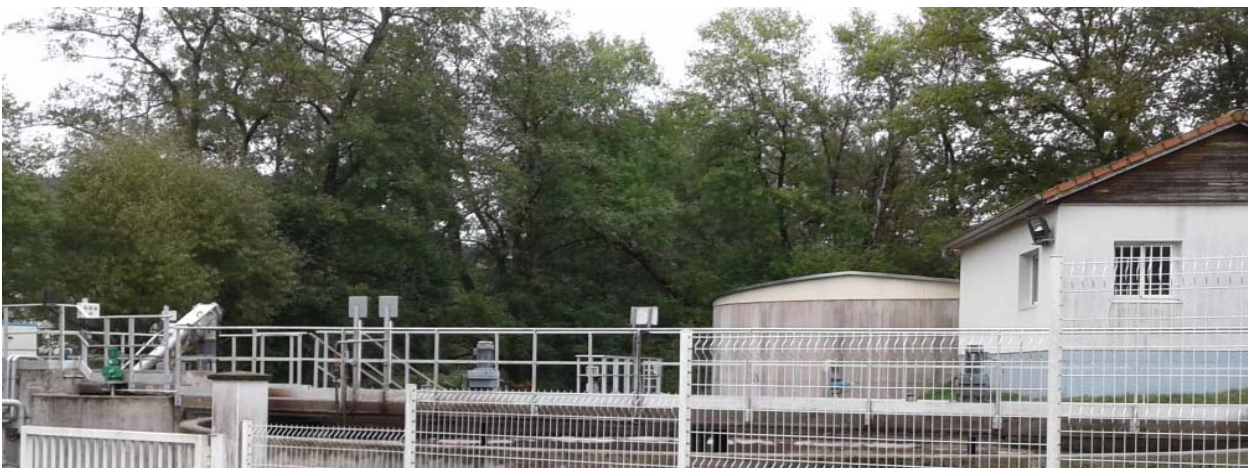
La station d'épuration - 2016
