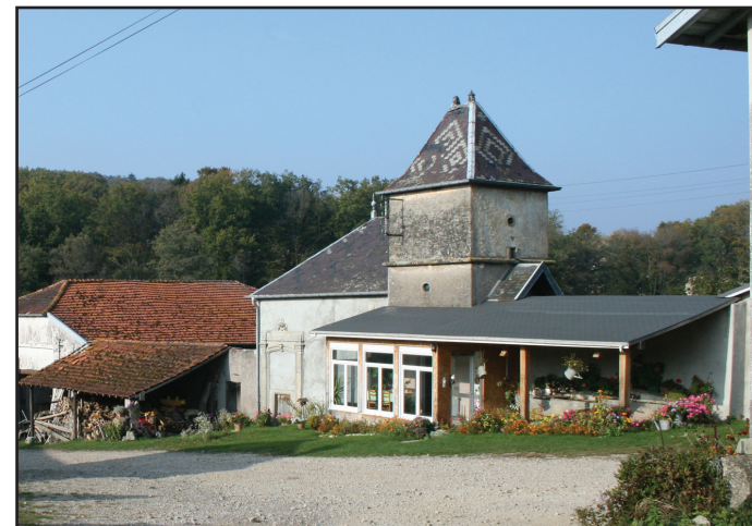
l'ancien prieuré de la ferme d'Aubiey
