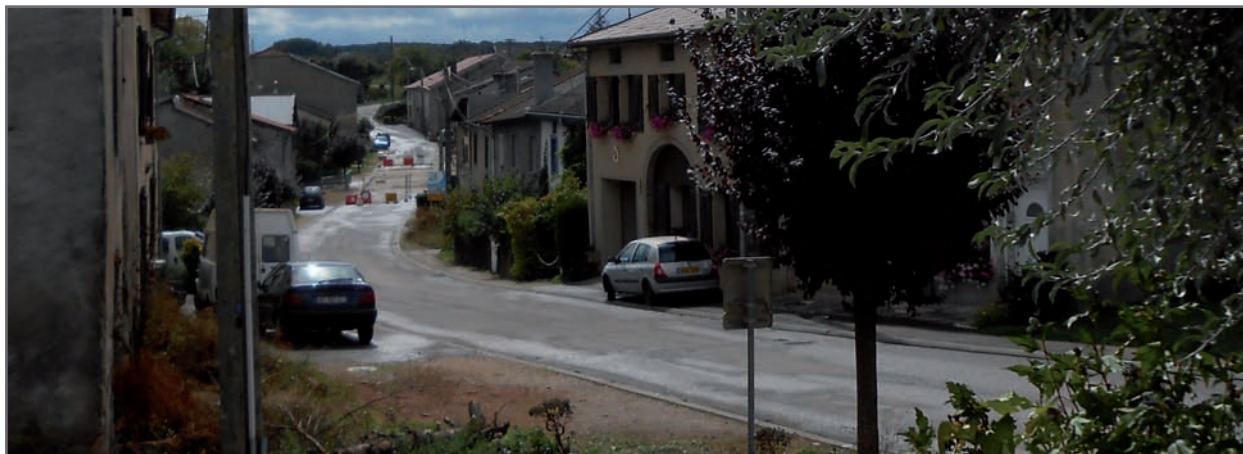
la RD3i (rue du Moulin)
