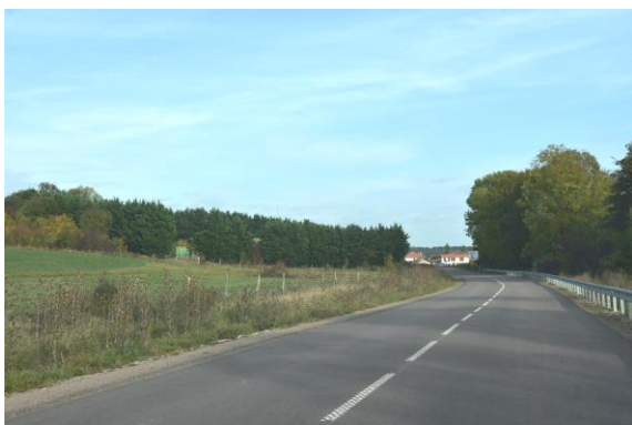
Vue depuis la RD 13, en provenance du village de Mandres-sur-Vair (sens Sud / Nord)
