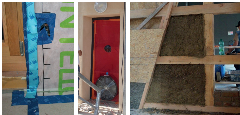
Exemple de mises en oeuvre et de systèmes visant la performance énergétique et la réduction des émissions carbone : étanchéité à l'air, test d'étanchéité à l'air et construction en matériaux biosourcés.
