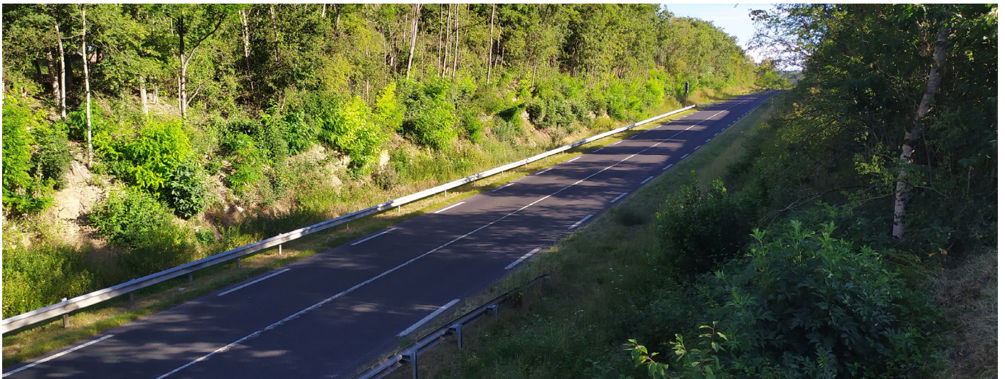
RD46 passant en contrebas de la parcelle de projet et dont les abords sont arborés
