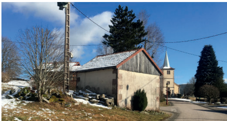
Les constructions les plus anciennes de la création du village de Liézey - Photographies Ici et là 2022.
