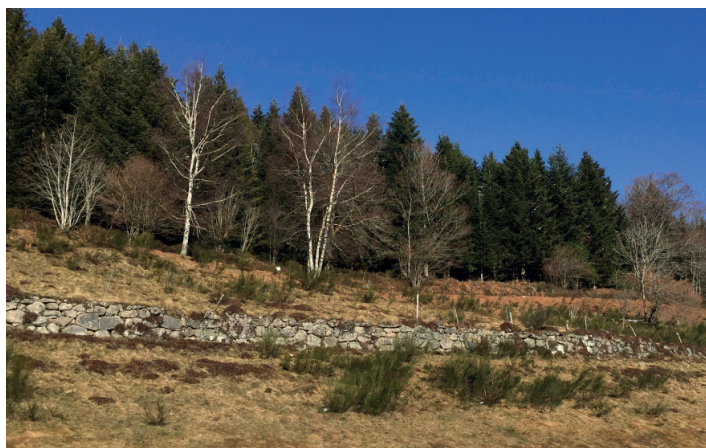
Murs de «gés» en pierre sèche, soutenant une terrasse et un fiaran. Photographie du Ici et là 2022. et Photographie du Fiarans : Extrait du «Blog d'un Pouhha»
