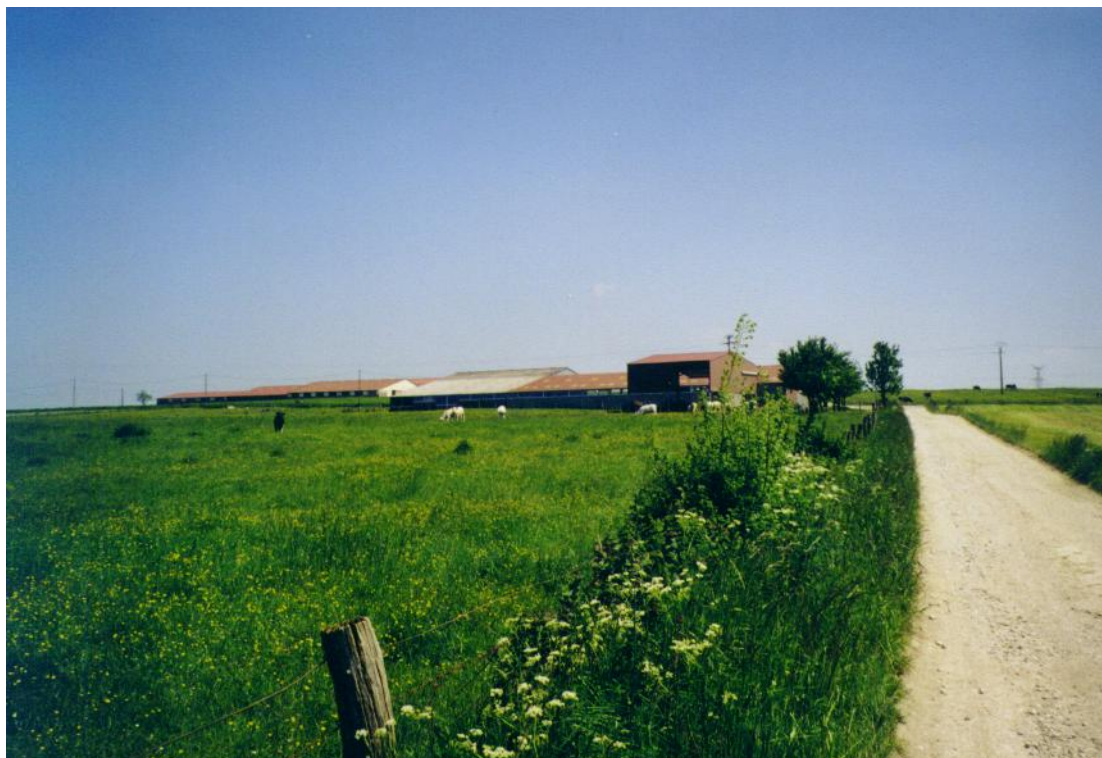
Photo 20 : bâtiment d'implantation du menuisier
