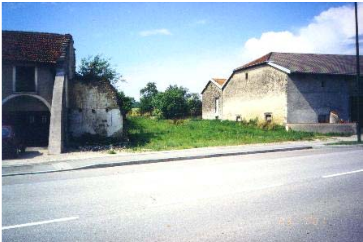
Photo 6 : accès futur vers la zone AU située derrière l'église
