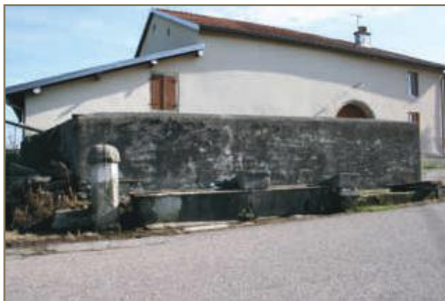
Fontaine située rue de la Maxièrre - Hameau de Guménil - 2011
