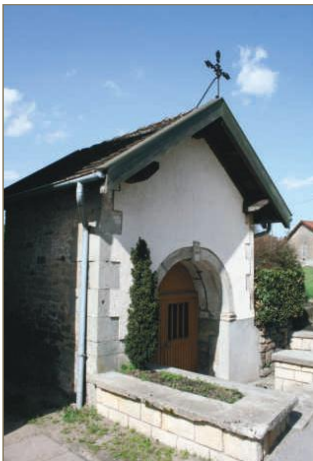
Chapelle Saint-Gengoult - rue de la Chapelle Hameau de Hadol Basse - 2011
