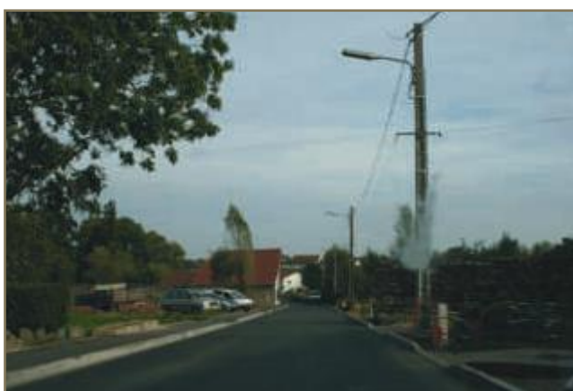
Rénovation de la rue de la Poste - 2011
