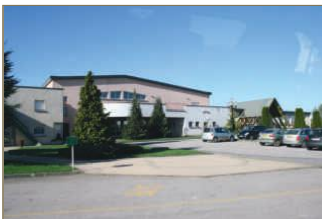
Le pôle d'équipements : un seul bâtiment pour trois fonctions - Rue du Stade - 2011
