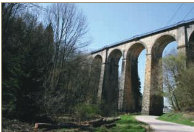
Ouvrage d'art ferroviaire - Viaduc de Granges situé au sud du territoire - 2011
