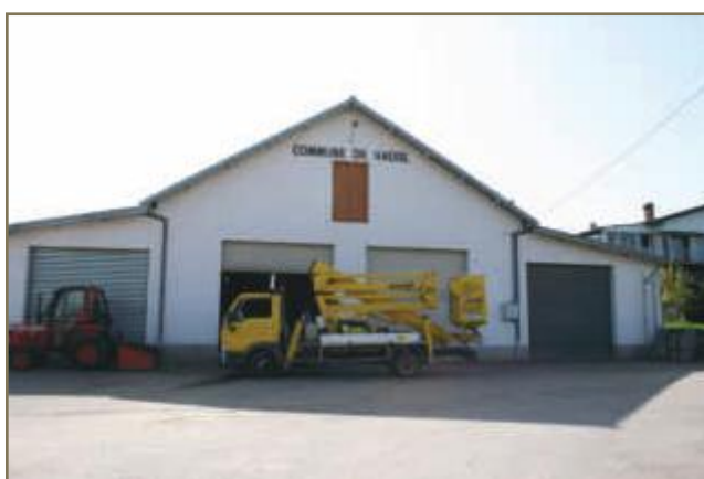
Services techniques de HADOL - à proximité du cimetière - 2011
