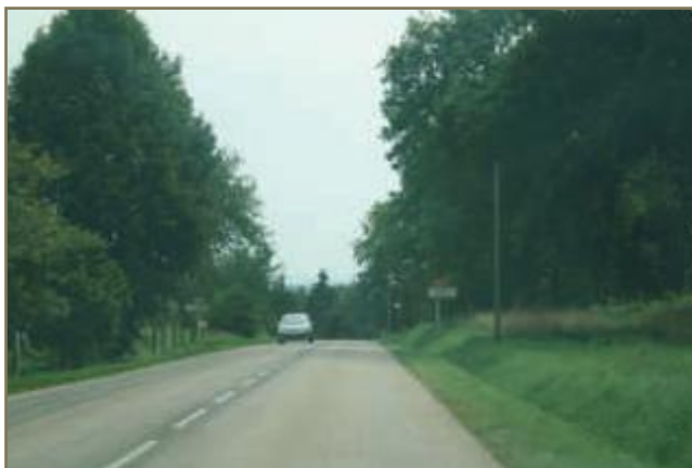
RD 12 - Route d'Epinal à l'entrée de Hadol Haute - 2011
