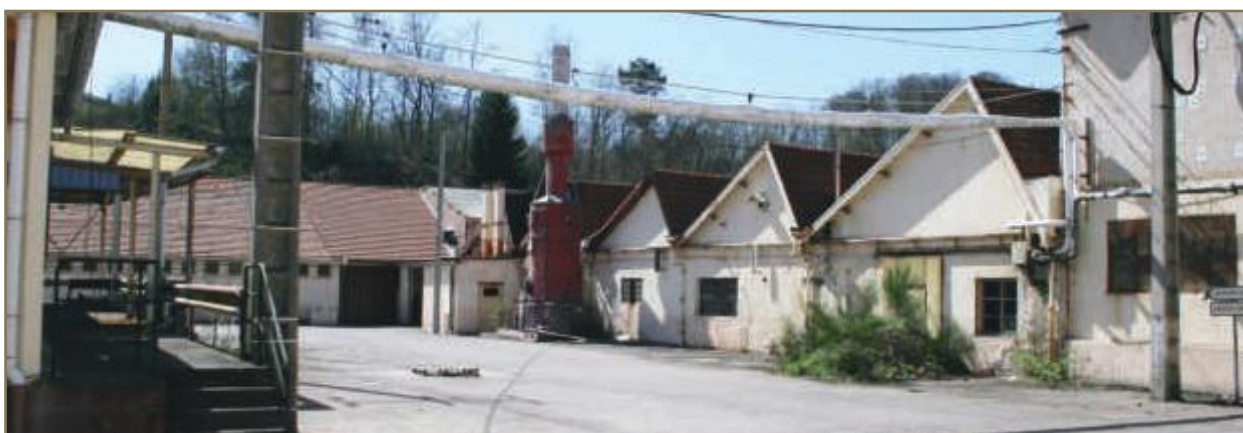
bâtiments de l'ancienne tréfilerie de Conflandey - 2011
