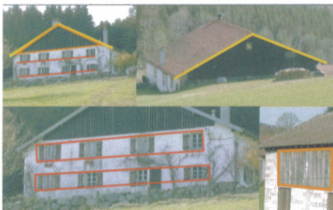
La pente du toit, l'alignement des fenêtres, les pans de bois en haut des murs, des caractéristiques fortes des fermes et de l'architecture vosgiennes.
