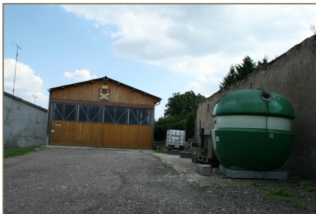
Bâtiment des services techniques municipaux situé rue du lavoir - 2011
