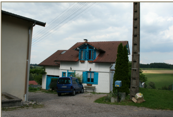
maison des années 90 - rue de l'école - 2011
