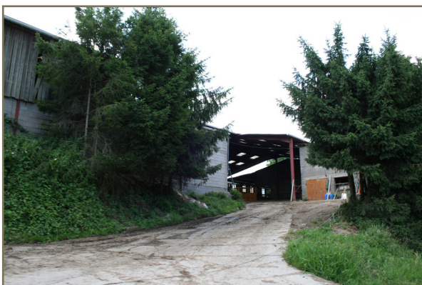
Hangar agricole situé rue de la poirière - 2011
