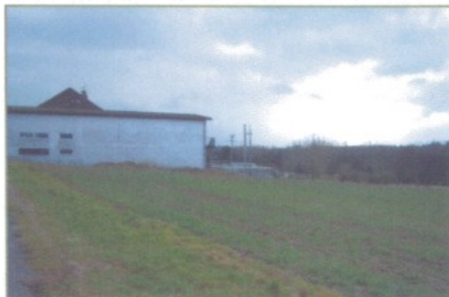
Chaudière bois située à l'arrière des bâtiments publics
