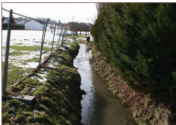
des travaux ont été réalisés sur le ruisseau de Fontenay pour lutter contre les inondations
