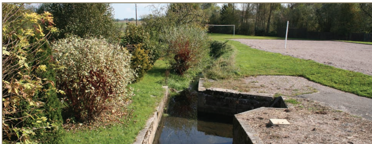
le ruisseau de Fontenay traverse la partie basse du bourg. Sujet à des débordements, son cours a été partiellement aménagé - 2011
