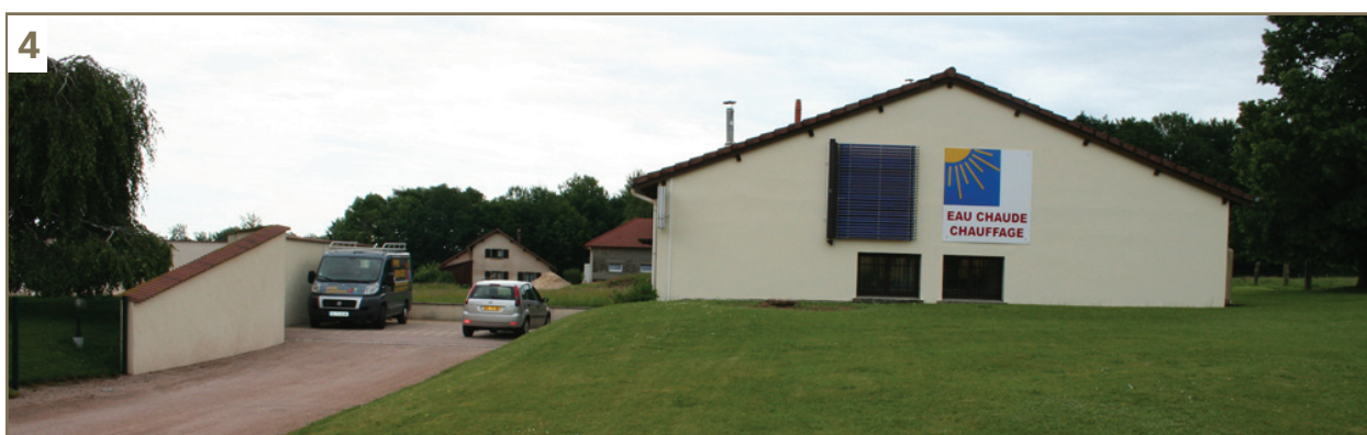
récupérateur de métaux, en bordure de la RD420 (1), boulangerie-pâtisserie en centre-bourg (2), caves de Fontenay en centre-bourg (3), entreprise de chauffage, chemin des Senseaux (4) - 2011
