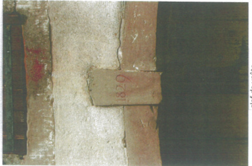
clef de voûte
