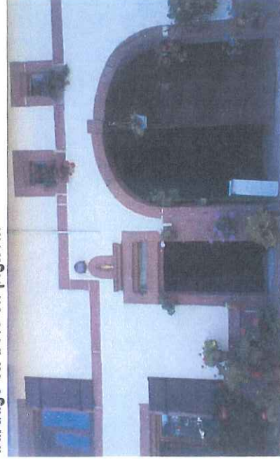
Façade sur rue d'une ferme traditionnelle marquée par du grès, pierre locale de construction soulignant les encadrements des ouvertures.
