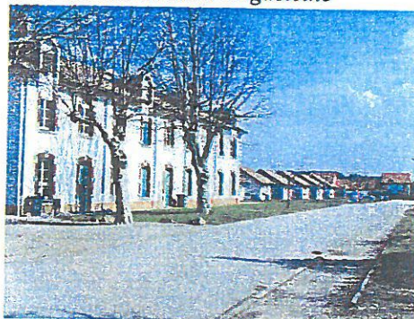
Administrations, associations et logements dans la caserne de la Magdeleine
