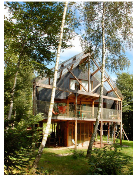
Construction surélevée dans les arbres (Chantraine - Haha architecte)
