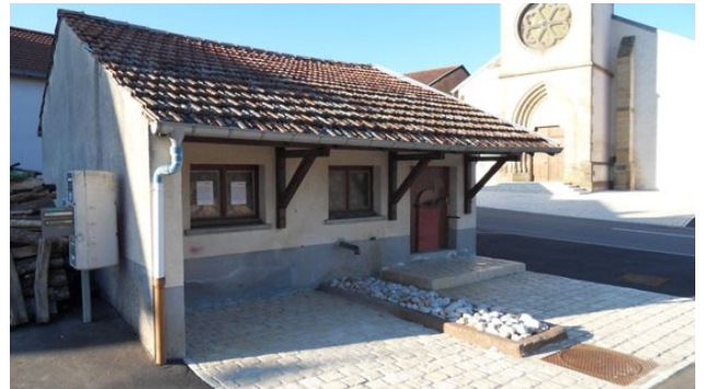
Mise en valeur du lavoir à Domvallier
