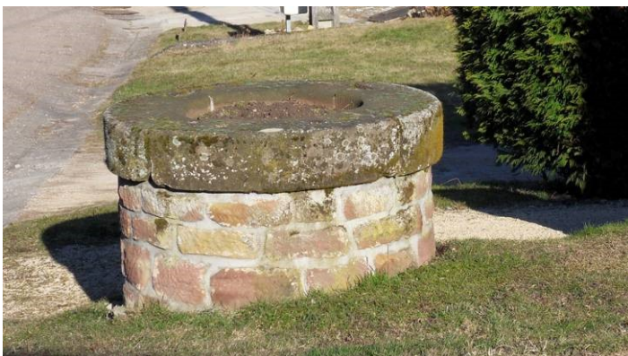
Puits à Domvallier
