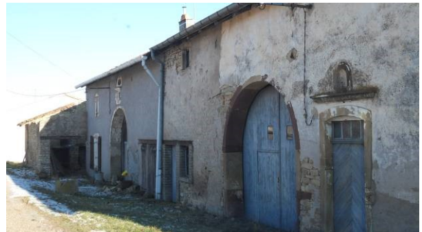
Exemple de logements à réhabiliter
