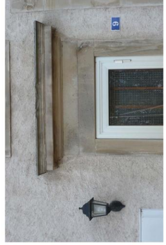
52- Encadrement et linteau de porte, 9 rue de Château
