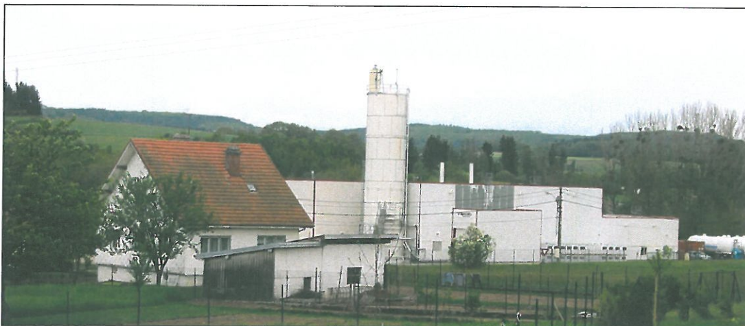
Photo n°11 : Bâtiments de l'entreprise Speciality Minerals (Vue orientée vers le Nord-Nord-Ouest)
