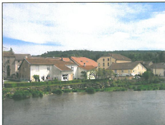
Photo n°10 : La Vologne, à l'ouest de la passerelle piétonne
