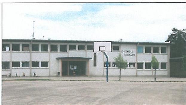
Photo n°37 : Groupe scolaire de DOCELLES
