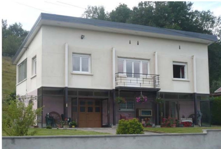
1- Maison ossature métallique, 551 rue de la Roche Guérin
