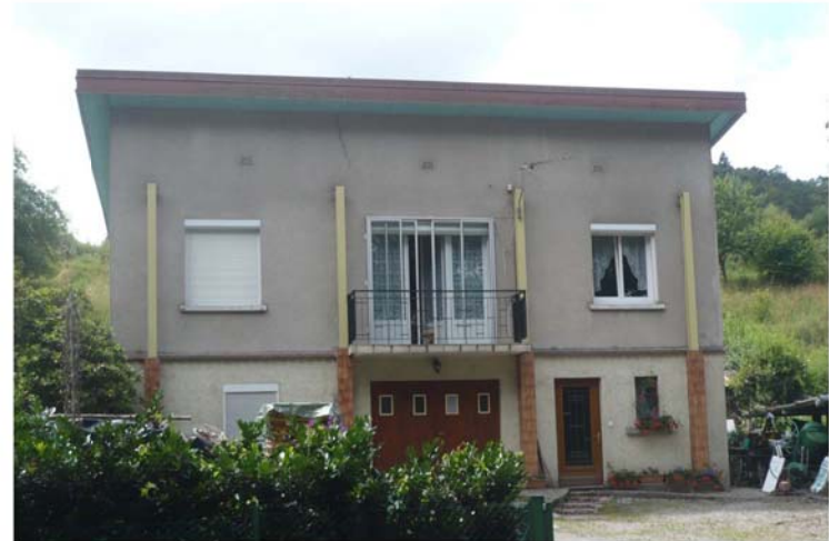
2- Maison ossature métallique, 253 rue de la Roche Guérin
