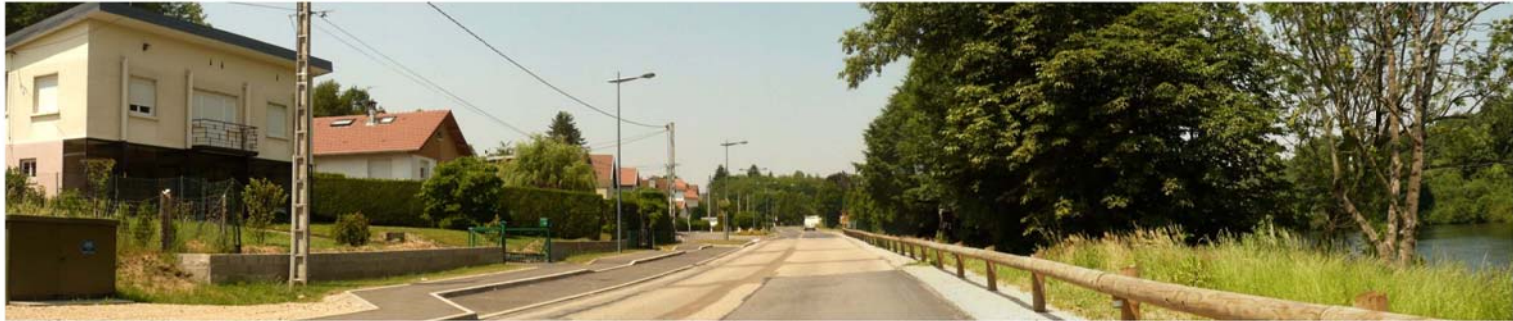
Aménagement des espaces publics le long de la RD157. Echappée visuelle sur la Moselle.
