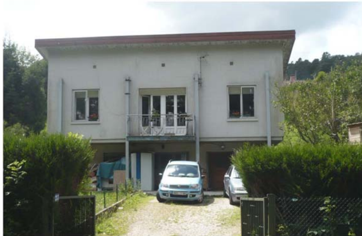
3- Maison ossature métallique, 271 rue de la Roche Guérin
