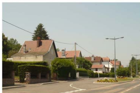
Une contre allée permettant une bonne structuration urbaine.
