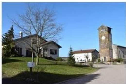
En cœur de village, suite à démolition
