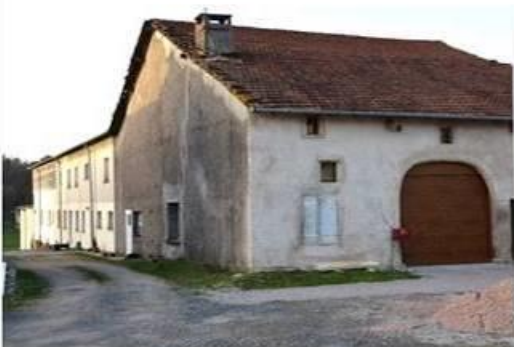
Préservation de la façade sur rue et création d'un appartement dans le volume adossé à l'arrière
