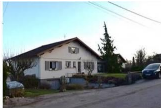
Extension linéaire des années 1970 dite « le lotissement »
