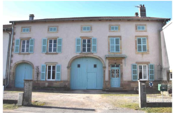
11 - Façade rue Saint-Vincent
