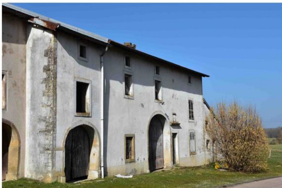
8 - Façade rue Saint-Vincent
