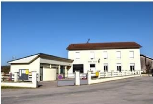
Réaménagement en cours d'étude, dont mise aux normes pour accessibilité
