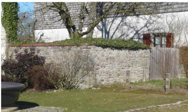
14 - Muret en pierres sèches rue de la Praye
