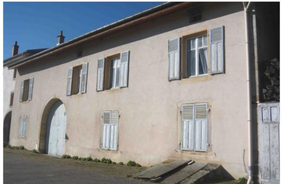
9 - Façade rue de la Praye
