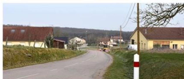
Depuis Longchamp (RD 66) Une voie prochainement recalibrée par le Département
