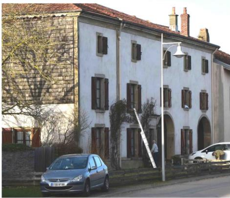
10 - Façade rue de la Praye
