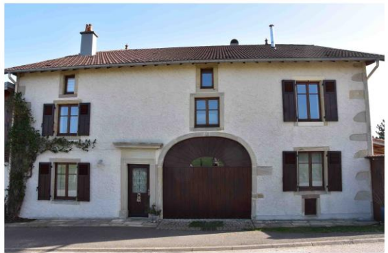
7 - Façade rue Saint-Vincent
