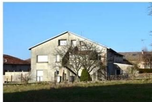
Exploitation d'un imposant volume bâti ancien pour créer trois logements
