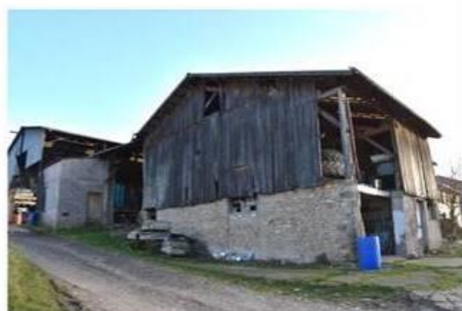
Permis de construire délivré pour création de deux logements dans ce volume à réhabiliter
