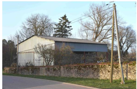
15 - Muret en pierres sèches rue du Paquis
