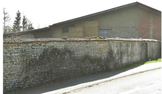
13 - Muret en pierres sèches rue Saint-Vincent
