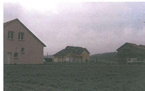
Le bâti diffus sur les pentes
