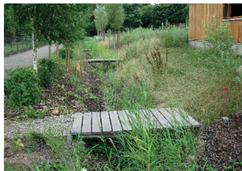
Exemple de noue fonctionnelle et paysagère, surfaces perméables de gestion des eaux de pluies (Sainte-Croix-aux-Mines - 68)
