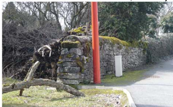
6- Muret en pierres sèches, 7 rue des Pensées
