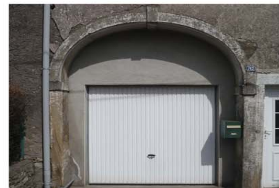
22- Encadrement porte charretière, 742 rue de Mirecourt
