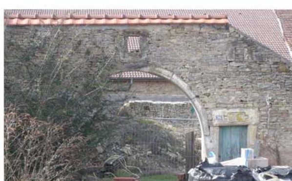
15- Encadrements porte charretière et porte d'entrée, 395 rue de Mirecourt
