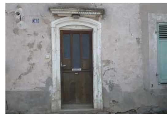
19- Encadrement porte d'entrée et linteau sculpté, 163 rue des Roseaux
