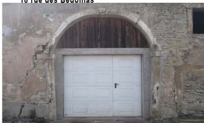
23- Encadrement porte charretière, 749 rue de Mirecourt
