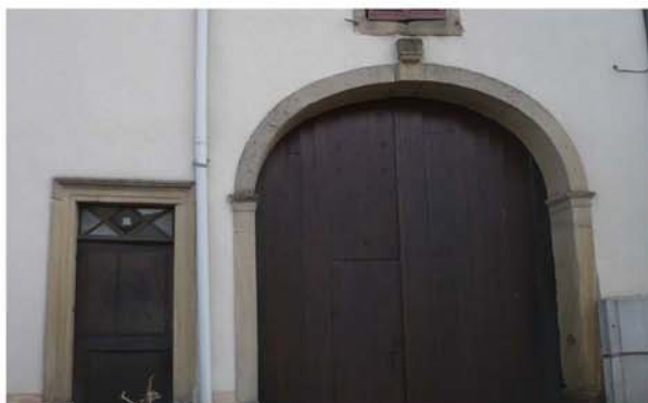
14- Encadrements porte charretière et porte d'entrée, 135 rue de Mirecourt
