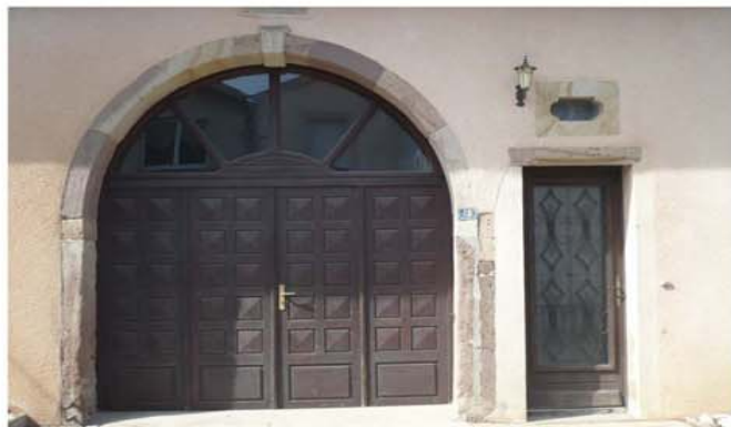
20- Encadrement porte charretière, 18 rue des Béonias
