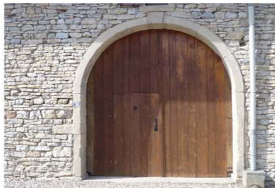
21- Encadrement porte charretière, 36 rue des Béonias
