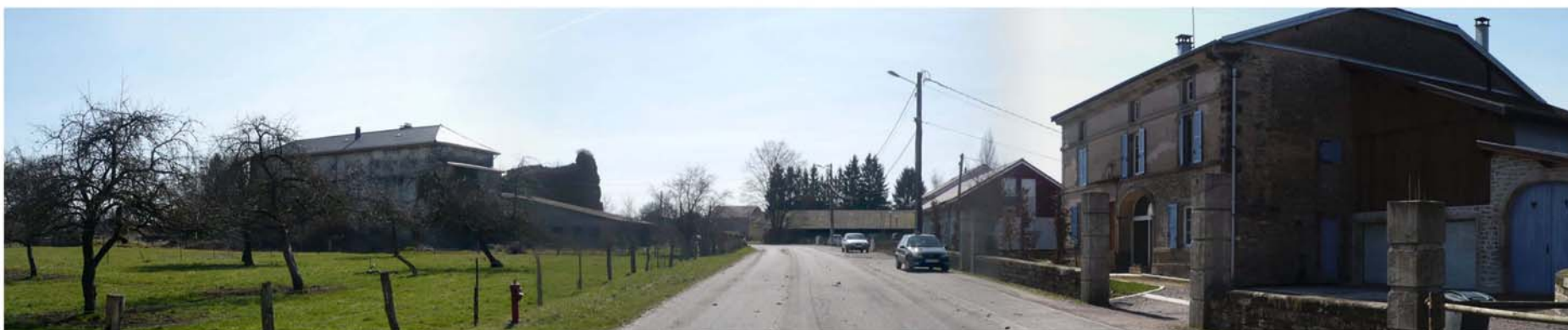
Entrée Nord depuis Fomerey (RD36), mi rurale mi urbaine, à fort caractère patrimonial : présence d'une ferme traditionnelle lorraine à droite et à gauche, un verger, composante du paysage vosgien
