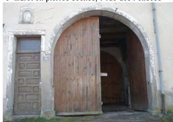
9- Porte à charri, encadrements porte charretière porte d'entrée, niche, 299 rue de Mirecourt
