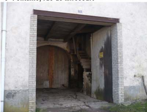
8- Porte à charri, 315 rue de Mirecourt
