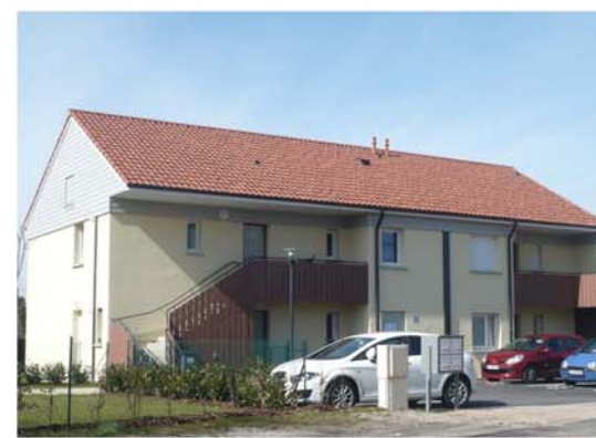
Logements de type habitat intermédiaire
