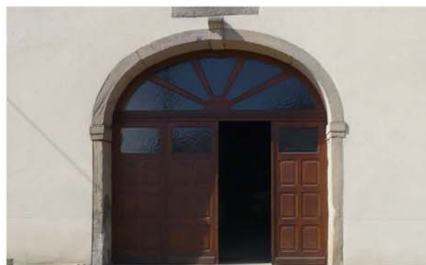
18- Encadrement porte charretière, 227 rue de Mirecourt
