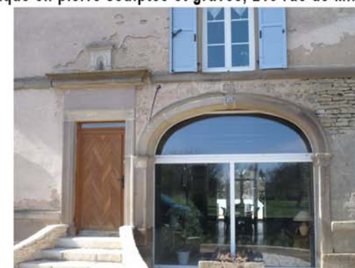
10- Encadrements porte charretière porte d'entrée, linteau, niche, 271 rue du Château
