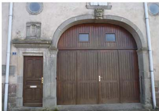
11- Encadrements porte charretière porte d'entrée, linteau, niche, 7 rue des Pensées
