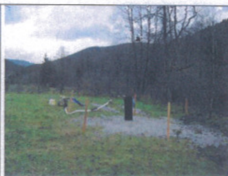
Forage F2 état actuel
