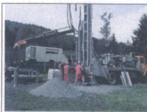
Forage F1 en cours de réalisation
