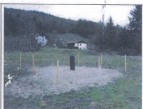
Forage F1 état actuel
