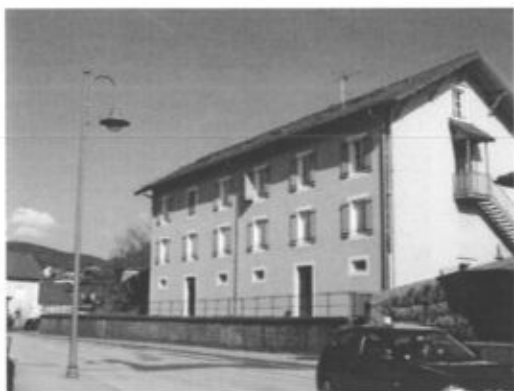
Cité réhabilitée : couleur jaune pâle et plaques fibro-ciment en façade pignon
