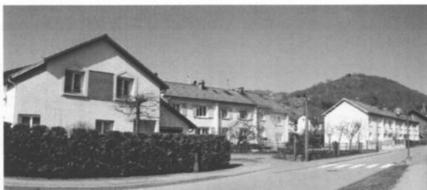
Cités réhabilitées, Passage Perrin
