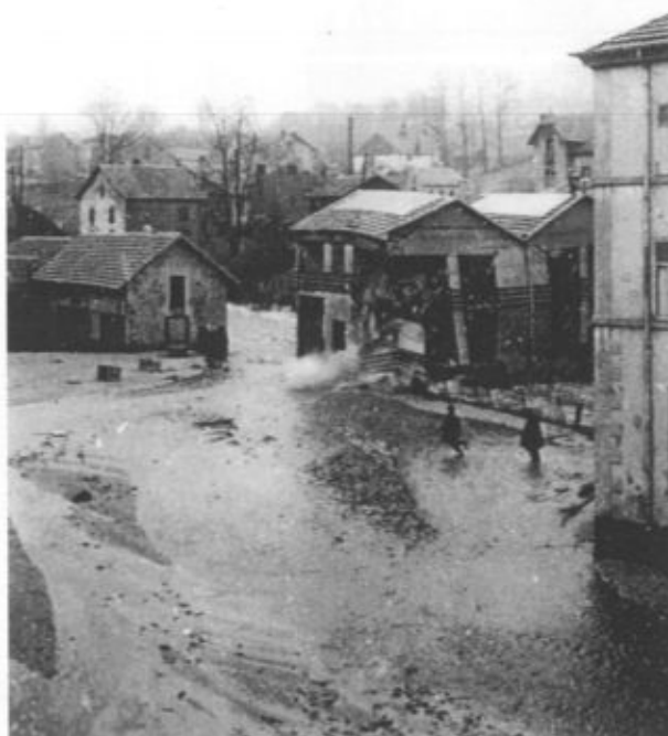
Ruisseau de Xoulces : crue de 1947, éboulement d'un bâtiment Place de la Pranzière
