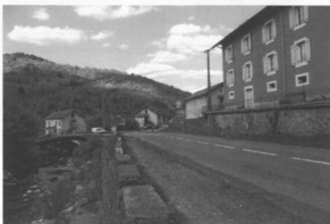
Les cités, le torrent, une conduite forcée, une route de montagne avec soutènements en granite, une ferme isolée sur le versant opposé... : c'est Cornimont !
