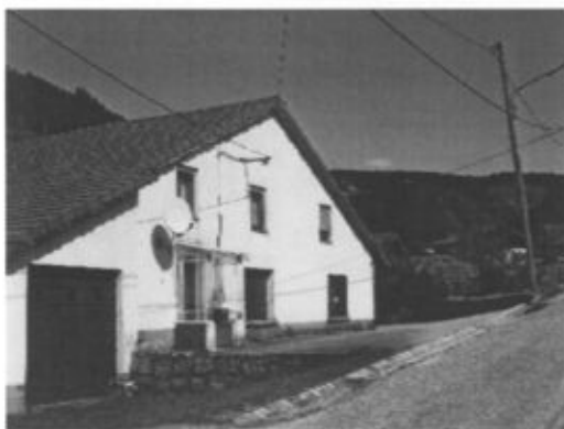
Habitat ancien : rez-de-chaussée + combles
