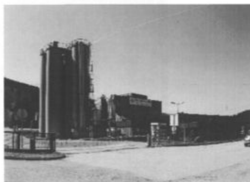
Bâtiments industriels avec silos
