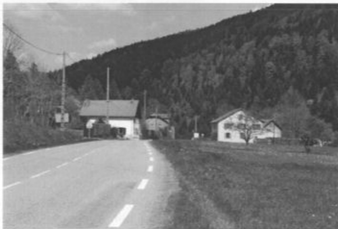
Entrée de Travexin en venant du Ménénil.
