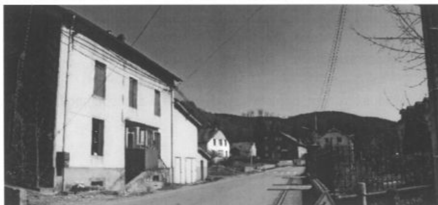
Le long de la Rue des Grands Meix, les distances entre la rue et les bâtiments varient.
