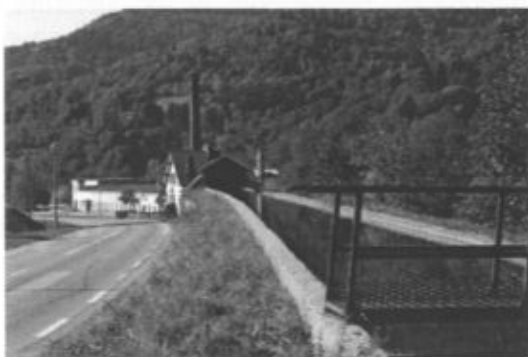
Canal de force hydraulique à Lansauchamp.
