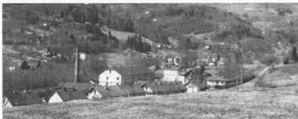
Le bâti industriel (fabrique et cité) le long de la Route de La Bresse
