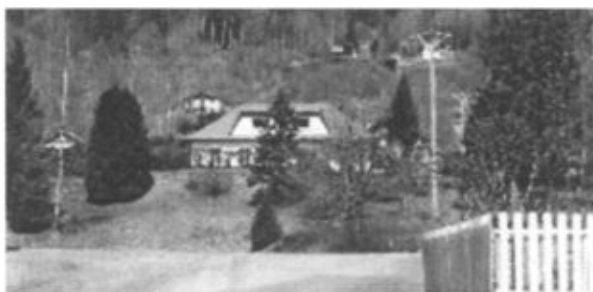
Maison « Ile de France » : toiture à 4 pans, en ardoise
