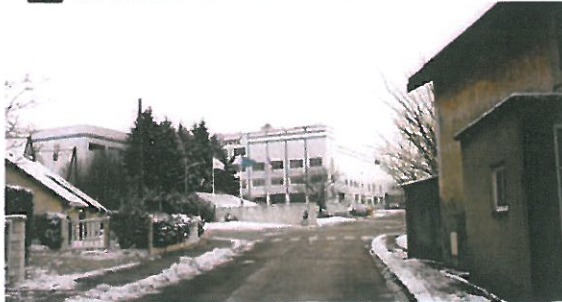
Vue sur l'usine d'embouteillage depuis la rue de Lorraine.
