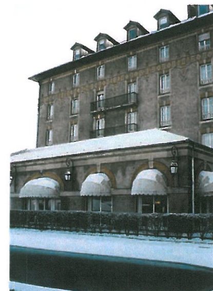
Façade de l'Hôtel Cosmos animée par le volume du restaurant et la piscine.
