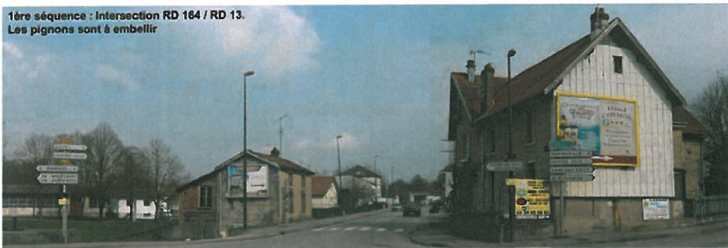
2ème séquence : La voie ferrée franchit la RD 164. Aménager les abords de la rue. Redondance de panneaux publicitaires. Traiter le pont et les talus de la voie ferrée.
