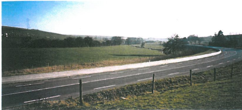
RD 164 : Entrée de ville en venant de Dombrot-le-Sec. Vue vers le Sud
