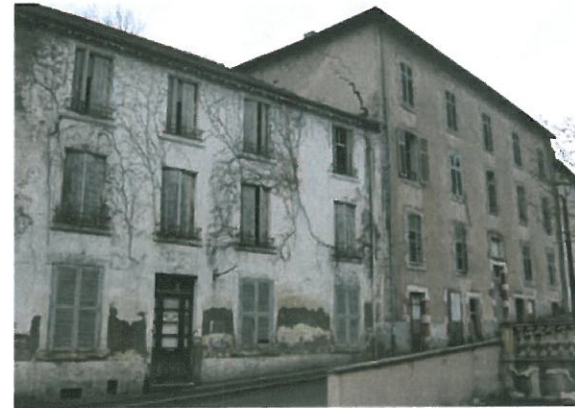
Importants volumes à l'abandon rue du Docteur Bagard
