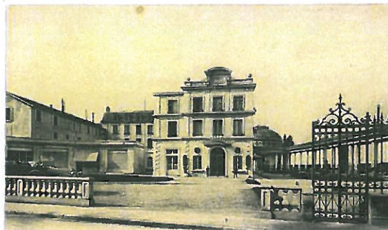
vue ancienne du Grand Hôtel de l'Établissement et la Cour d'Honneur. Ce bâtiment a été récemment démoli.
