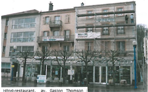
Hôtel-restaurant, av. Gaston Thomson : La véranda nuit à la qualité du bâti.
