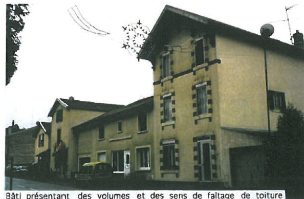
Bâti présentant des volumes et des sens de faitage de toiture non homogènes.
