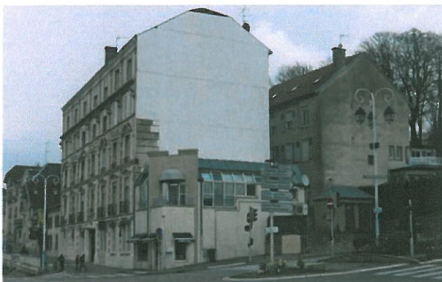
Angle av. du Shah de Perse/av. du Bois d'Hazau : maîtriser le traitement du pignon.
