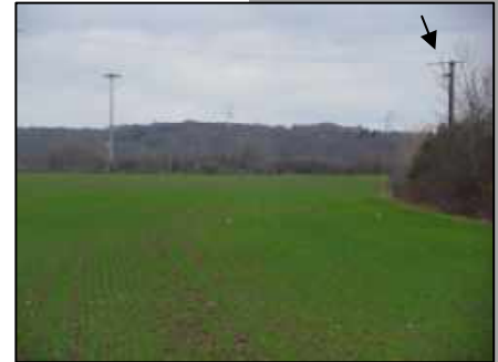
Ligne alimentant la Seurie
