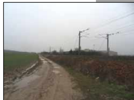
Voie ferrée et son fossé à préserver
