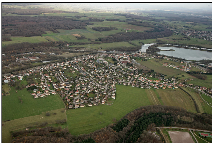
Vue aérienne sur la partie nord de Chavelot
