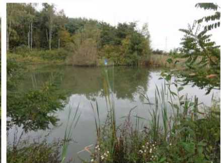
Actuel bassin de collecte et de décantation des eaux de ruissellement (ENCSEM)
