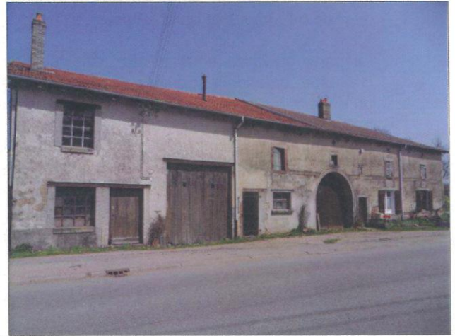
Habitat caractéristique du village-rue lorrain, dans le cœur originel de Chaumousey : grande façade avec porte charretière.
