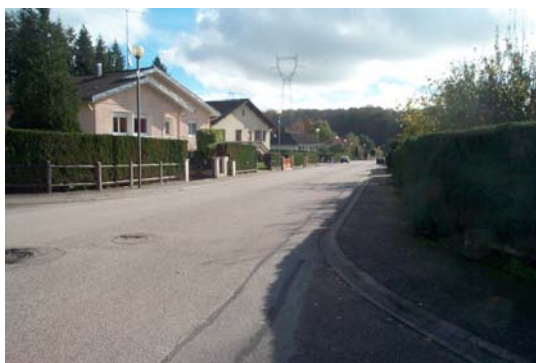
Photo : Maisons individuelles du lotissement " La Pucelle"
