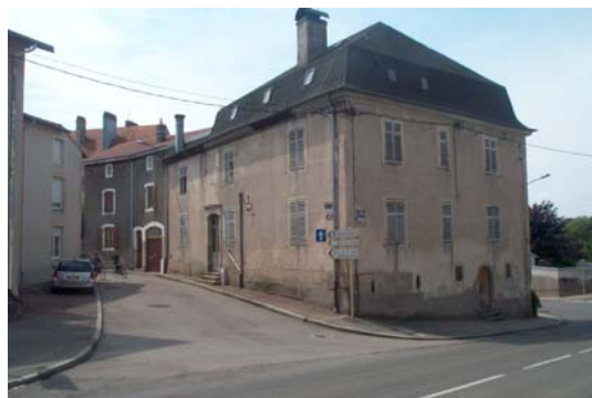
Photo : Immeuble du XVIII ème siècle
