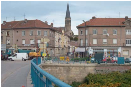
Photo : Vue à 180° du pont de la Moselle
