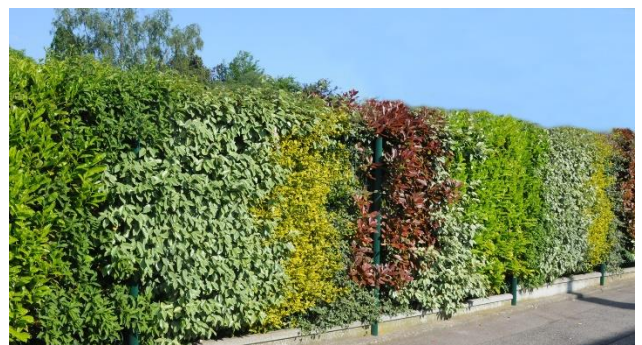
Dispositif à claire voie, doublé par une haie vive avec mur bahut inférieur à 80 cm de haut
