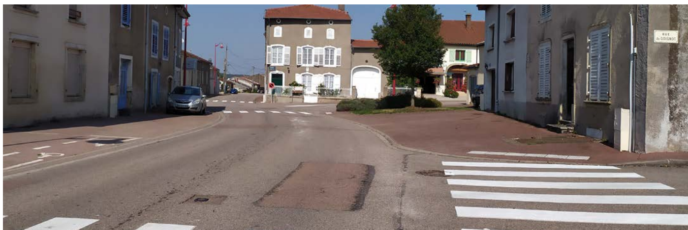
La RD9 constitue la colonne vertébrale du village - photographie éolis 2020
