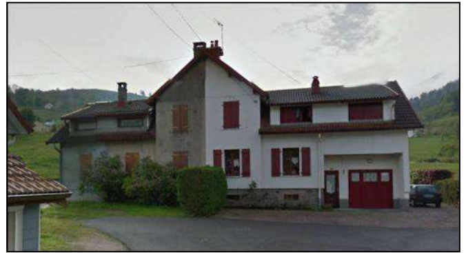
Habitat ouvrier rue de la Paix
