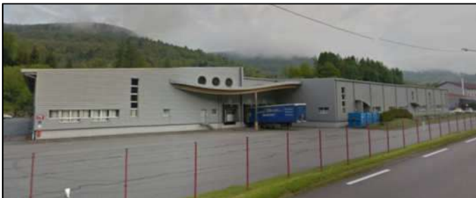
Usine Fackelmann : Fabrication et distribution d'articles de ménage et de cuisine
