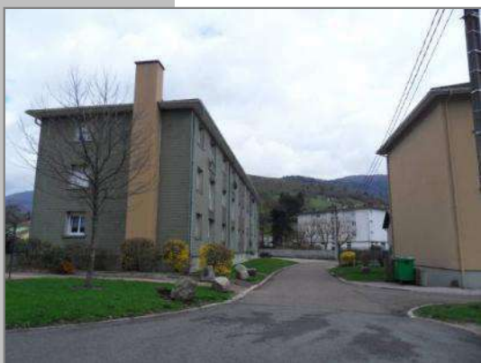
Logements collectifs, rue Maurice Pottecher.
