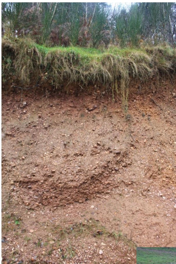
Photographie 3 : Front de déblais, Rue du Pré Ballon
