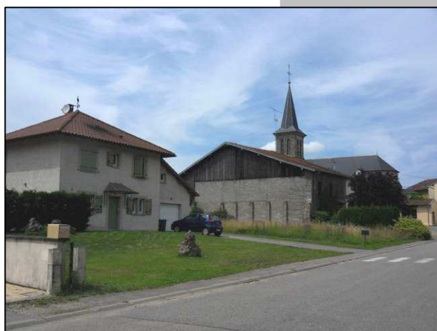
Construction récente dans une dent creuse , Grande Rue
