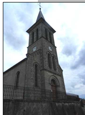
Eglise, Rue du Saint-Bout
