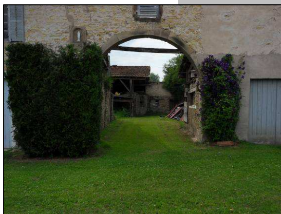
Courette de transition, rue du Saint-Bout
